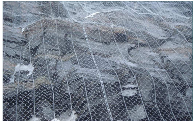
Applicazione in parete di Steelgrid HR System
