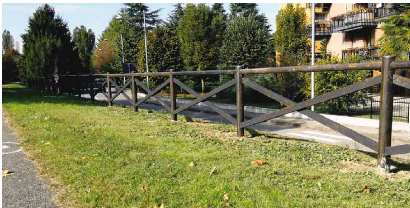
3A e 3B. La staccionata Cadore è disponibile anche con diagonali in legno, ma in questo intervento è stata utilizzata la versione con tutti gli elementi in acciaio Cor-Ten
