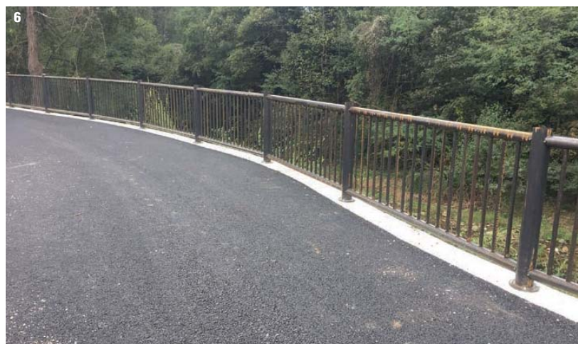
6. Valdagno (Vicenza): esempio di parapetto Falcade
